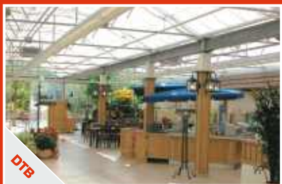
Stilgebend – Stahlträger mit Holzverkleidungen teilen den Raum auf.
