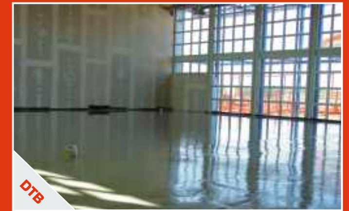
Aus einem Guss: 2.800 m 2 Fliesestrich baute DTB an einem Tag ein.
