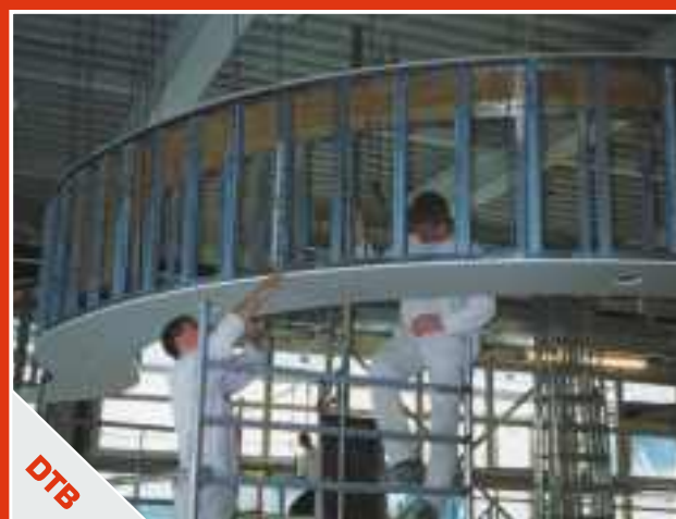
6 Café Ein Stein: Aufbringung der Gipskartonplatten auf die freihängende Abschottung.
