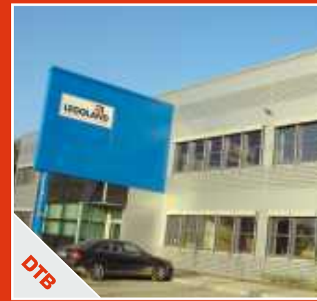
1 Verwaltungsgebäude: 2.500 m 2 Decken und 5.500 m 2 Wände.
