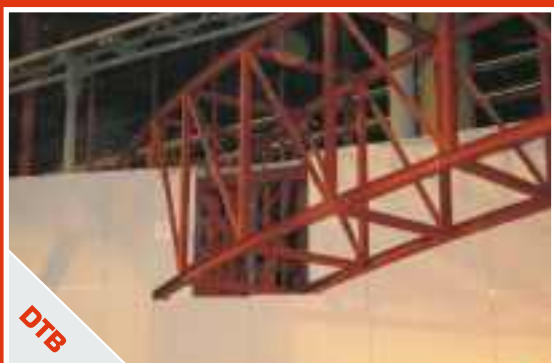
Freitragende Stahlträgerverkleidung im HUB 3000.
